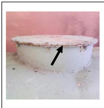
Fig. 2. Accesibilidad. Observe el espacio entre las dos bridas, tiene una separación menor que 50 mm.
